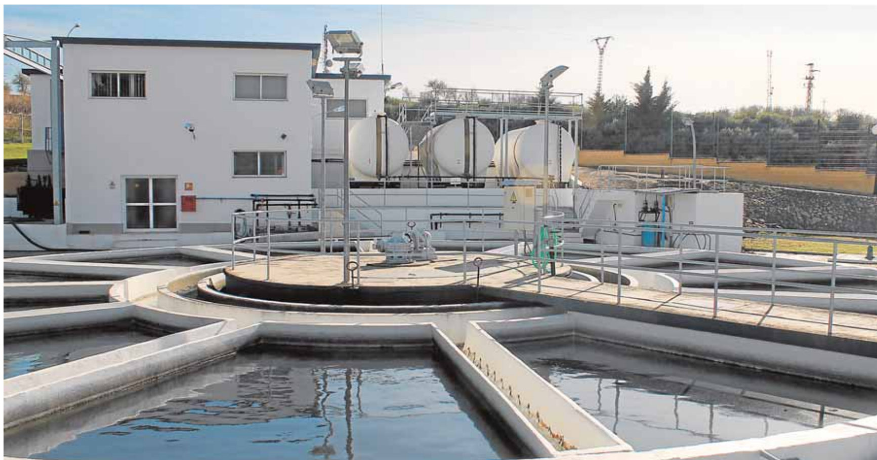
Las nuevas instalaciones deben estar ejecutadas al 80% a finales de 2015, por lo que podrían estar listas a principios de 2016
